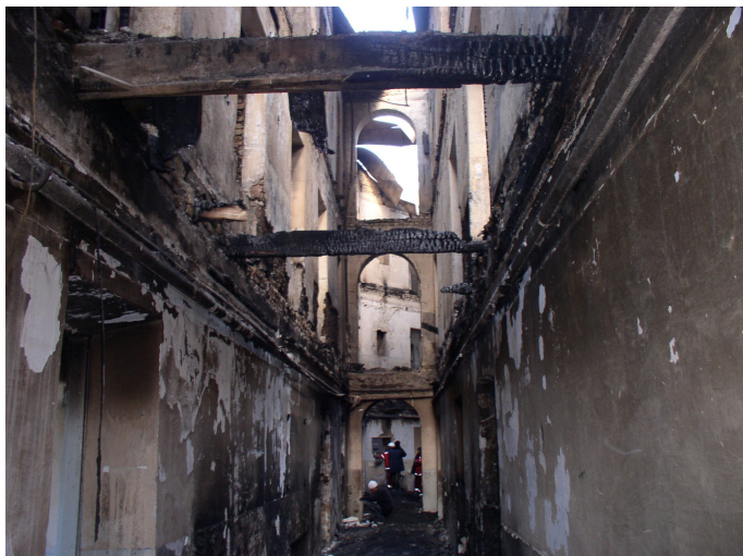
Рис. 4. Сгоревшее перекрытие коридора.
