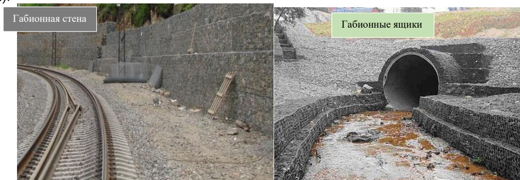
Рисунок 8- Габионная конструкция из металлической сетки на железной дороге и во входном оголовке трубы под насыпями
