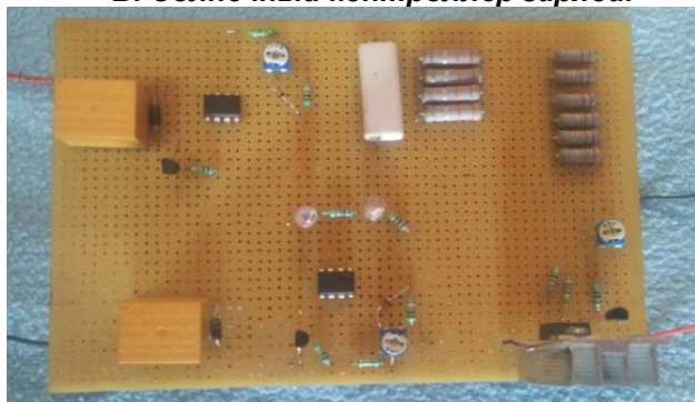
Рисунок 3- Контроллер заряда солнечной батареи [2].
