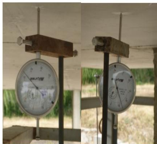
Рис.6. Прогибомеры часового типа ИЧ 50 установленные под плитой для измерения прогиба плиты при различных этапах статического нагружения.
