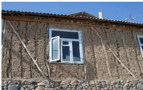
Рис.4. Каркасная стена из глиняного кирпича (Айтский район)
