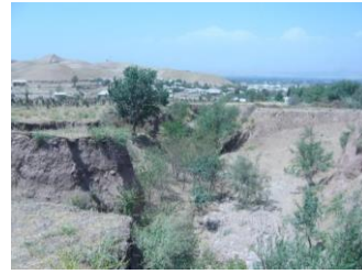
Рис. 2 Развитие эрозионных промоин на склоне с северного подхода на ПК4км (вид на север)
