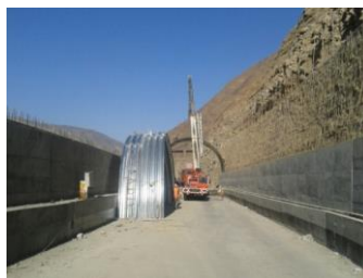
Рис. 5. Монтаж СГЛ
