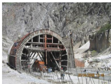
Рис. 1. Металлическая опалубка для противолавинных галерей
