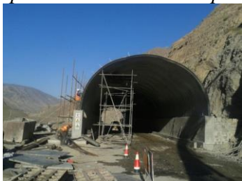
Рис. 6. Подготовительные работы по армированию галереи
