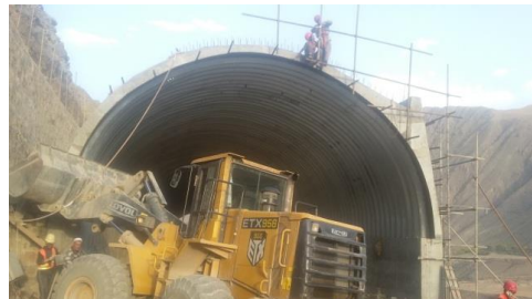
Рис. 9. Противолавинная галерея после бетонирования
