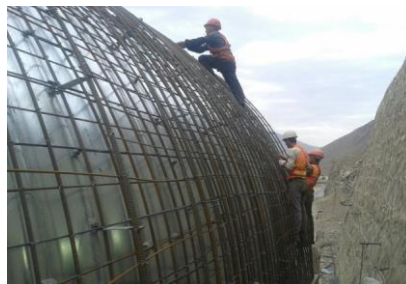
Рис. 7. Армирование обделки галереи
