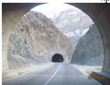
Рис. 3. Общий вид эксплуатируемых противолавинных галерей на а/д “Душанбе-Худжанд-Чанак”
