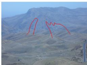
Рис. 6 Вид на оползни на ПК16 км в районе кишлака Чучу-поён
