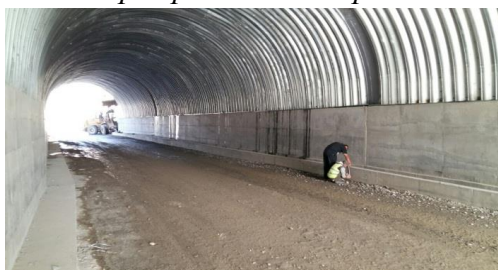
Рис. 8. Противолавинная галерея на 26 км а/д Айни - Пенджикент
