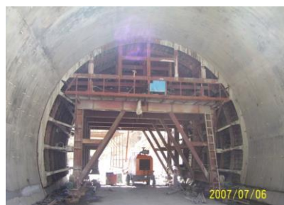
Рис. 2. Момент бетонирования противолавинной галереи
