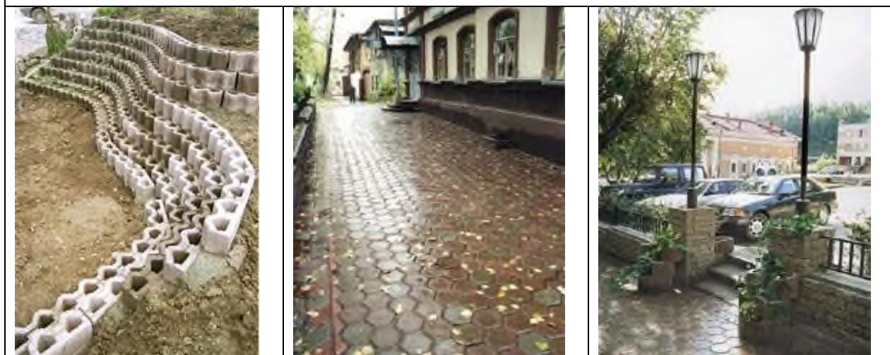
Рисунок 15 - Благоустройство территории и примеры укладки тротуарной плиткой улиц и дорог
