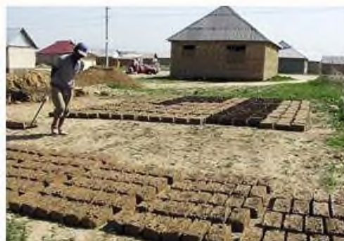
Рисунок 2. Формирование и высушивание сырцового кирпича
