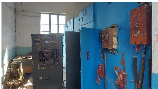
Рисунок 5 – а) ячейки шин РУ 6кВ
