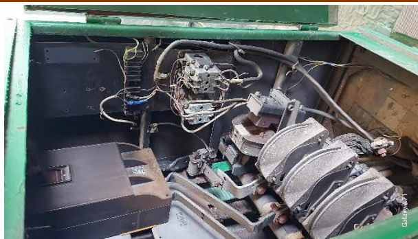
б) Внешний вид контактора для пуска и остановки электродвигателя
