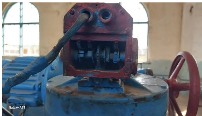
Рисунок 7 – Внешний вид реле времени автоматики открытия и закрытия затвора
