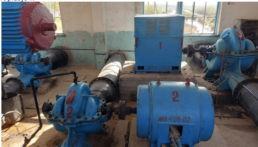
Рисунок 4 - Внешний вид электродвигателей 1,2, насосной станции Уртабуз-1 сроком службы более 50 лет
