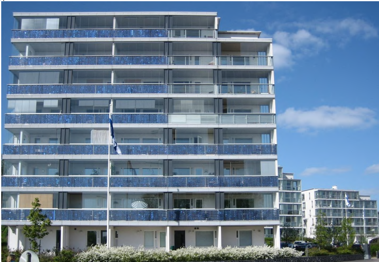
Рисунок 2 – Пример интеграции солнечных панелей в жилое здание (экологический квартал Viikki, Хельсинки, Финляндия, 2008 г.). Фотоэлектрические модули встроены в фасадный блок многоквартирного дома и обеспечивают децентрализованную генерацию электроэнергии на месте эксплуатации здания.
