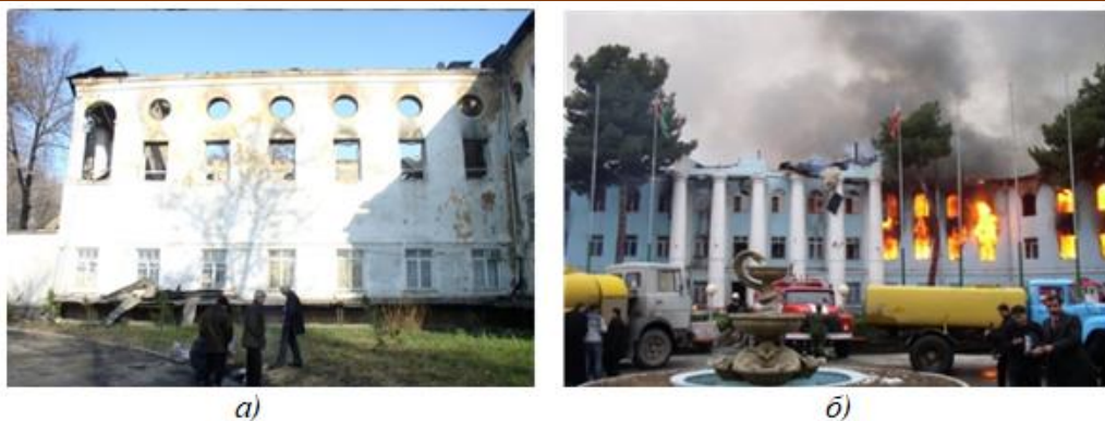
Рисунок 2 – Здание восстанавливаемого Таджикского Государственного Медицинского Университета а) каркас актового зала после пожара; б) фото главного корпуса во время пожара 25.12.07г.
