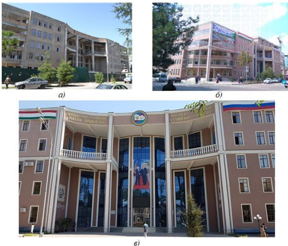
Рисунок 9 – Здание нового учебного корпуса Русско-Таджикского Славянского Университета Россия-Таджикистан" а) Фрагмент стадии строительства, б)фрагмент фасада бокового фасада, в)фрагмент главного фасада сданного в эксплуатацию 2016г..
