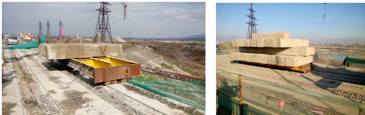
Рис. 3. Опытный образец балки в процессе испытания
