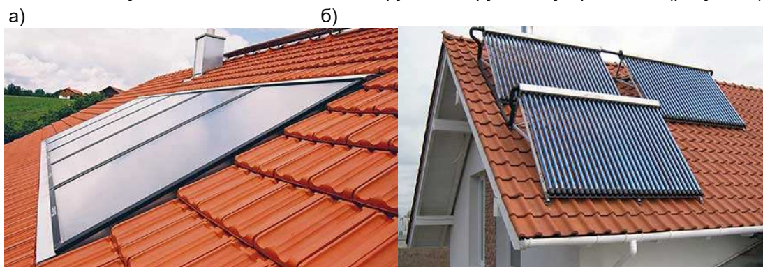
Рис. 2. Гелиоколлекторы на крыше дома: а – плоские, б – трубчатые вакуумные
