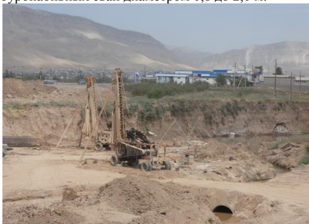
Рис.2. Установки буронабивных свай.
