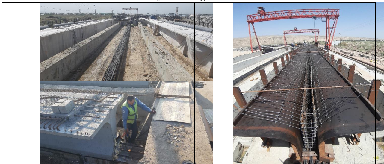
Рис. 5. Изготовление 18 и 33 метровых преднапряженных железобетонных балок автодороги Душанбе – Курган-Тюбе.
