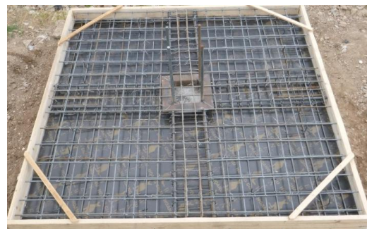
Рис. 8. Опалубка и схема армирования узла стыка плиты с колонной безригельного каркаса со смешанным армированием перед укладкой монолитного бетона
