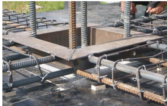
Рис. 2. Стальной опорный столик – воротник непосредственно при армировании этого узла смешанной арматурой; при смешанном армировании в опорном столике вместо двух средних стальных стержней устанавливается две базальт-пластиковой арматуры АБП.
