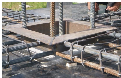
Рис. 2. Стальной опорный столик – воротник в процессе армирования узла стыка плиты с колонной; замкнутый уголок столика сваркой соединяется с рабочей арматурой колонны; опорная рабочая арматура плиты-балки создает арматурный каркас, который обеспечивает рамную систему в обоих направлениях
