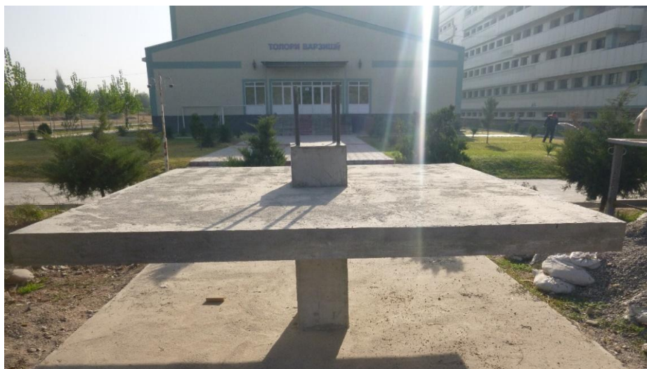
Рис. 9. Узел стыка плиты с колонной безригельного каркаса при смешанном армировании АБП в натуральную величину для статических и динамических испытаний
