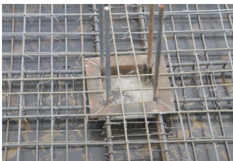
Рис. 7. АБП над опорным столиком перед бетонированием узла стыка плиты с колонной безригельного каркаса со смешанным армированием
