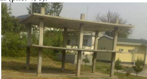
Рис. 3. Фрагмент двухэтажного здания с безригельным каркасом из монолитного железобетона в 1:2 натуральную величину с которым проводятся статические и динамические исследования
