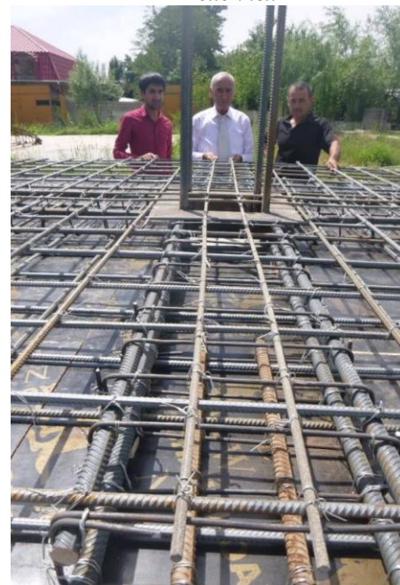
Рис. 6. Общий вид армирования узла стыка плиты с колонной безригельного каркаса при смешанном армировании; между рабочими стержнями колонны в двух направлениях над опорным столиком уложены по два АБП диаметром 10 мм и объединены армосетками и армокаркасами плиты вязальными проволоками.
