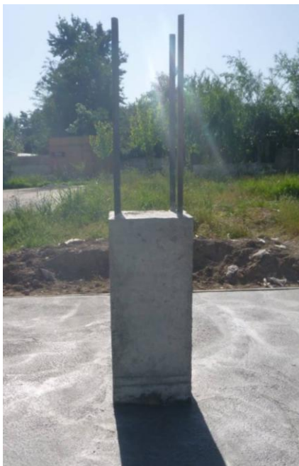
Рис. 5. Колонна с выпуском рабочей арматуры для создания узла стыка плиты с колонной безригельного каркаса из монолитного железобетона.
