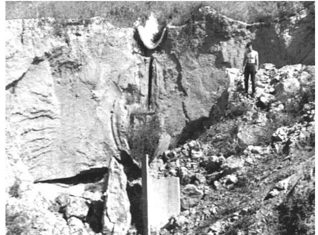
Рис. 4. В результате утечек воды из лотковой сети сформировался псевдокарстовый овраг в течение 1 суток (фото А.А. Лаврусевича)
