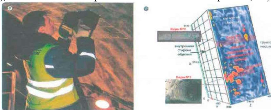
Рис. 1. Ультразвуковые топографические исследования в тоннеле метрополитена: а — процесс формирования результатов для построения трехмерной картины; б — результаты прозвучивания бетона обделки в виде трехмерного блока, отвержденные отбором керна
