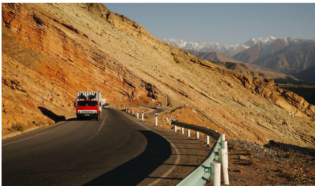
Рис.1. Горная автомобильная дорога Душанбе-Чанак (186-км)
