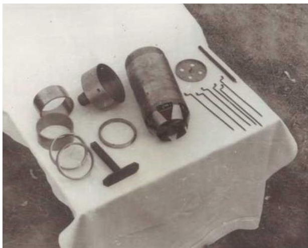
Рис.3. Конструкция грунтоотборника: а) - в разобранном виде, б) - в собранном виде с закрытой грунтоприемной камерой
