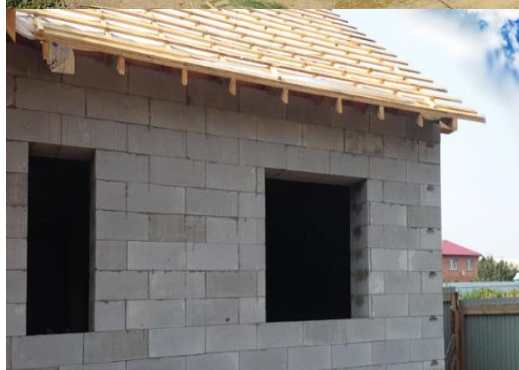
Расми 1 – Сохтмони биноҳо аз хиштҳои гилкоҳӣ ва газоблокҳо
