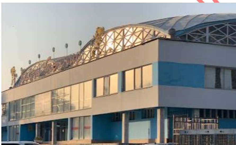
Рисунок 6 – Покрытия с монолитными оболочками положительной гауссовой кривизны, размерами в плане 48x48 Дворец тенниса в г. Душанбе (Таджикистан, монолитно-разрезной конструкции)
