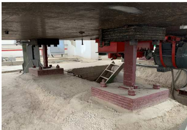
Рисунок 1. Опоры виброплатформы
